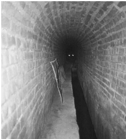
Figure 4. Side gutter. Bajo Abroñigal qanat
