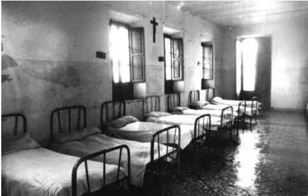
FOTO DEL PISO DE LA PARTE ALTA CONVERTIDO EN DORMITORIO
